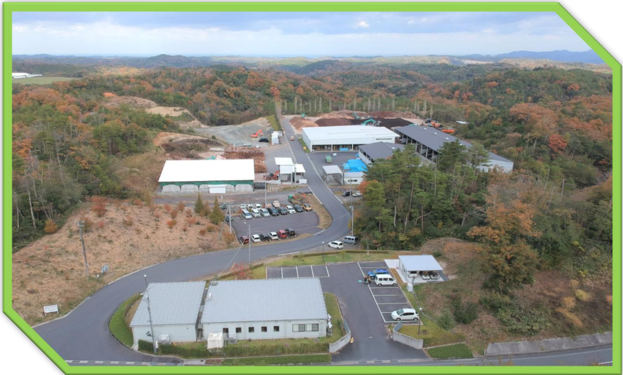
本社社屋及び小松地工場を望む
