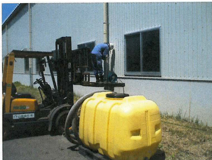
雨水利用設備作成中
