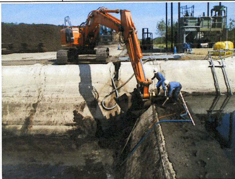
沈渣池清掃風景
